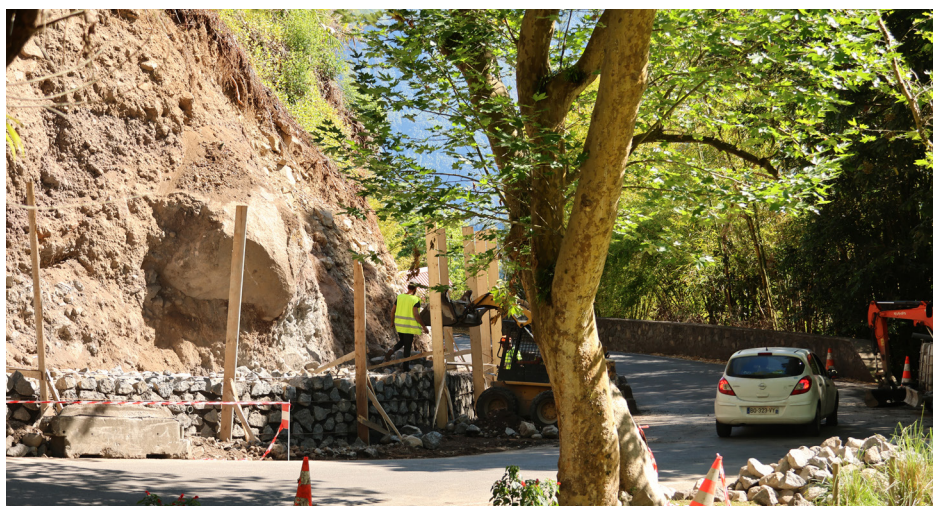
En haut • La construction du mur moellon sécurisant l'accès à Hell-Bourg.
